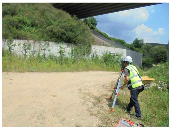
광파기를 이용한 측량 작업
